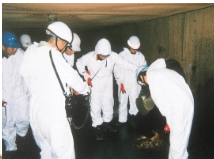
水切りノズル下の貫通孔
