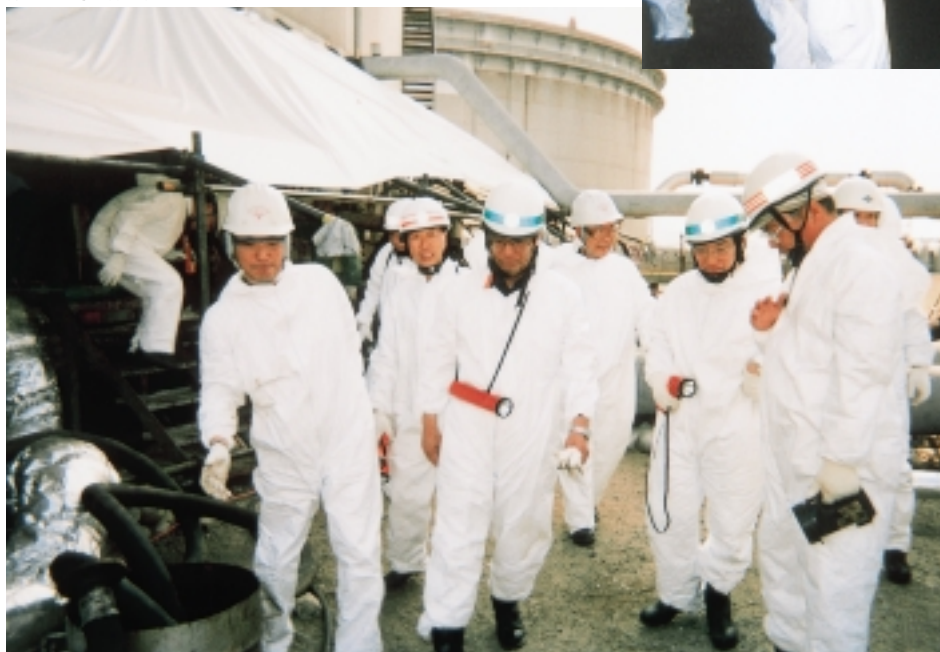
漏えい事故が発生した屋外貯蔵タンク
